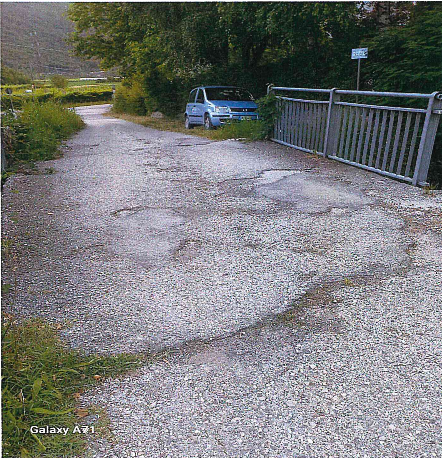
MANTO STRADALE SCONNESSO SUL PONTICELLO
