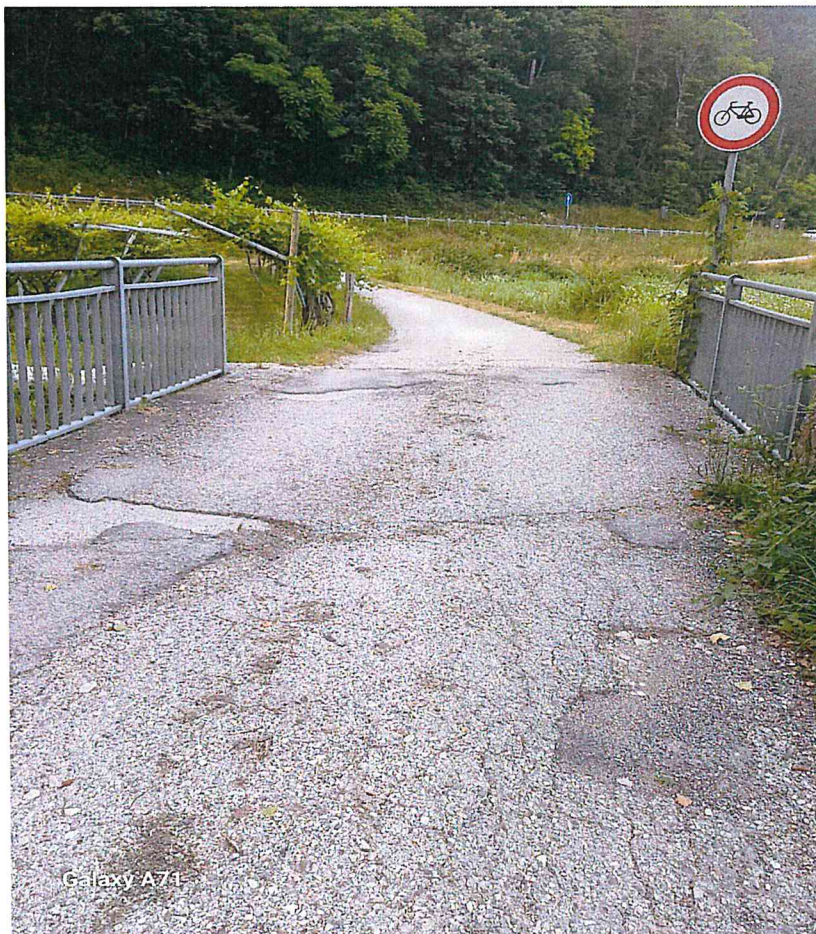
MANTO STRADALE SCONNESSO SUL PONTICELLO
